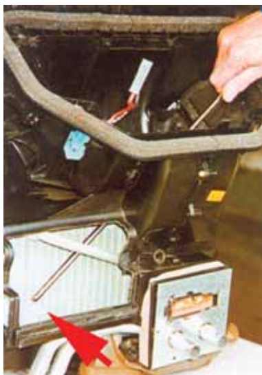
Fot.8 Na przekroju zespołu klimatyzacyjnego, strzałka wskazuje miejsce, w którym znajduje się końcówka sondy rozpylającej środek czyszczący. W rzeczywistości pracownik wykonujący czyszczenie nie widzi miejsca, w którym ta końcówka się znajduje. Pozostaje mu prowadzić sondę „na wycieczie”, a powinien to czynić tak, aby powierzchnia całego parownika została oczyszczona. (Źródło: Tunap)
